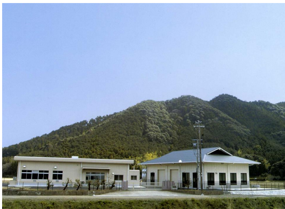
下市木・志原浄水場
