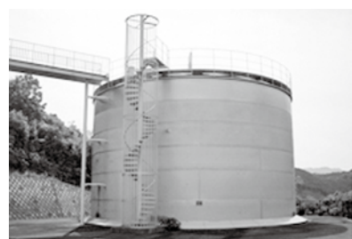
下市木・志原第2号配水池
