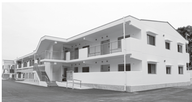
町営住宅外観
