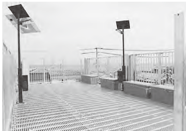
ソーラーライトを設置したステージ部分
