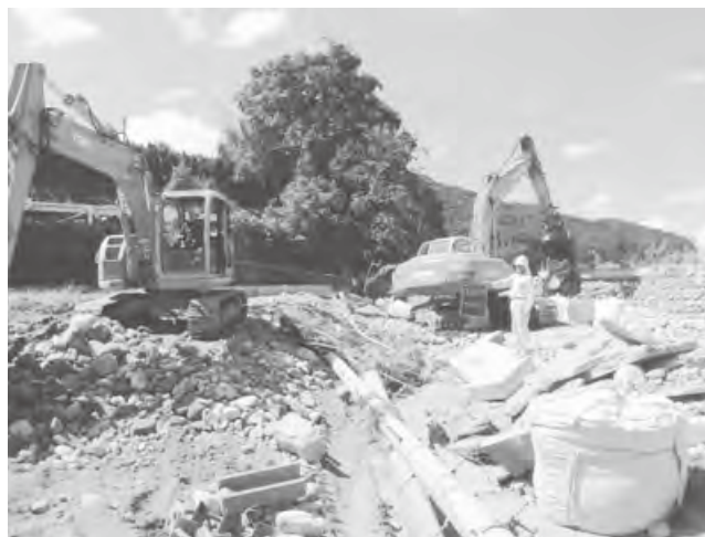
尾呂志川築堤護岸の応急対策工事
