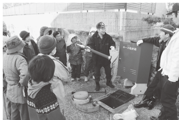
消火栓の使い方を教わる山地区民の皆さん
