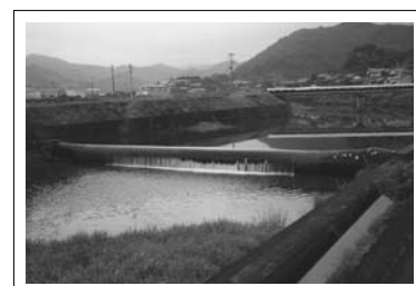
12 市木川空気ダム (下市木)
