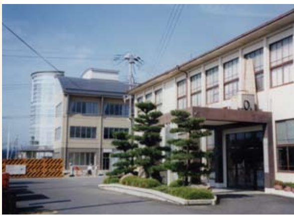
旧庁舎(手前)と工事中的の新庁舎(奥) (平成10年)
