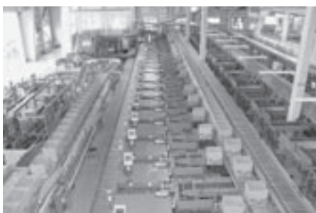
完成した新しいプラント
