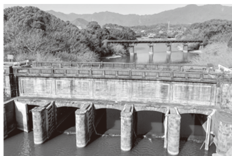
志原川河口の樋門
